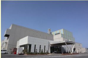
【島根原子力発電所3号機】
